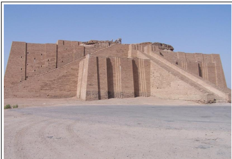
经过部分修复的吾珥城神殿。这座金字塔形神殿大致建于公元前 2100 左右，用于供奉月亮神南纳。注释1。
